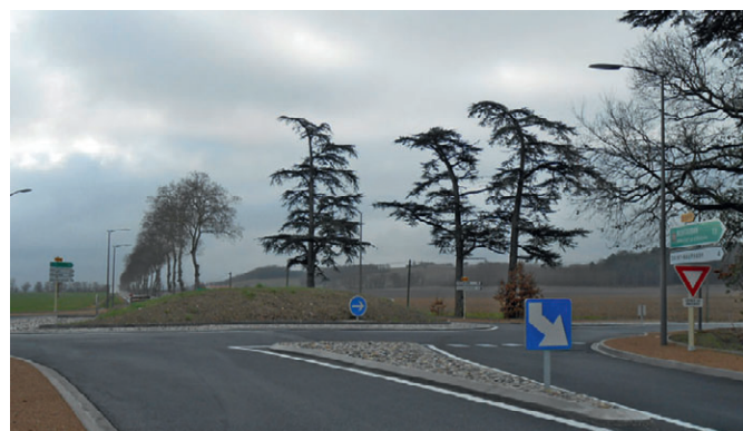
Giratoire RD 999 - RD 36 à Saint-Nauphary
