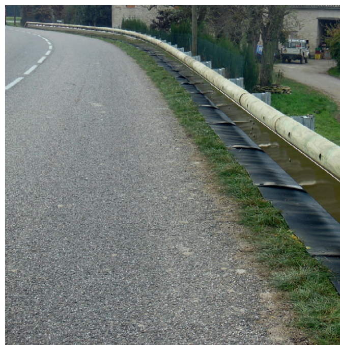
Glissières de sécurité sur la RD 953 à Auvillar
